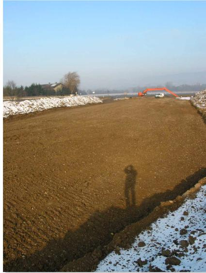
Schutzbau für die Familien Haidinger, sondern um eine Maßnahme, die Mitterau vor Hochwasser bewahren soll. Wie die Erfahrungen und Berechnungen zeigen, wird Mitterau vom dort befindlichen Durchlass her überflutet. Um dies zu verhindern, wird das Gelände jetzt erhöht.
